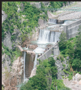
白岩砂防堰堤
