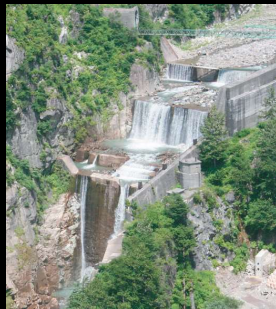
白岩砂防堰堤
